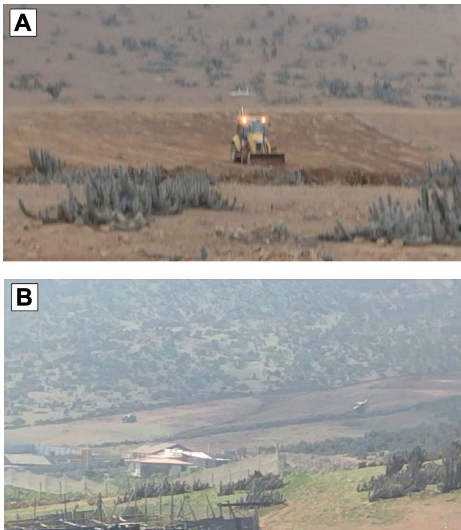
Figura 17. Maquinaria pesada realizando remoción de la capa de vegetación en la Estancia Panulcillo.
