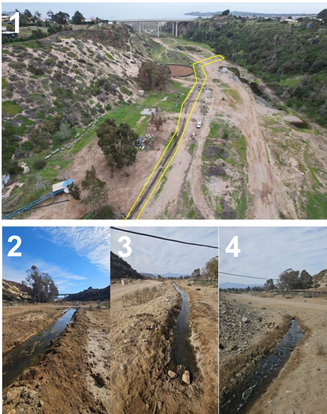
Figura 7. Composición de fotografías de la descarga de ESSSI durante la fiscalización de 2 de mayo de 2024.
