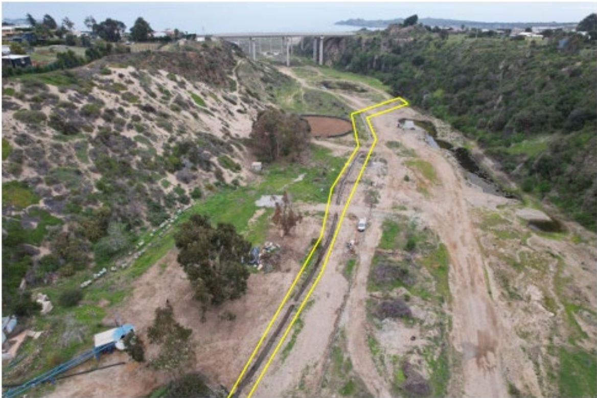
Figura 4. Registro fotográfico de la canalización de aguas de descarga en el cauce del río Quilimarí.
