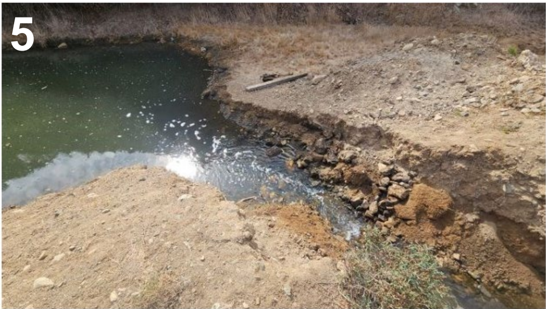
Nota: Fotografía 1) Canalización construido con posterioridad a la fiscalización de 2023, que conduce aguas abajo y atraviese el cauce del río Quilimarí; y, Fotografías N°s 2 a 5) Obras de canalización.
