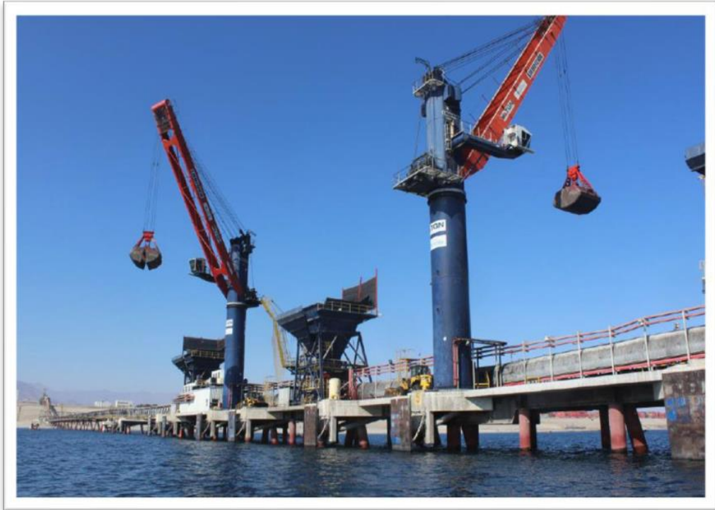
Figura 5: Imagen del Terminal 2
